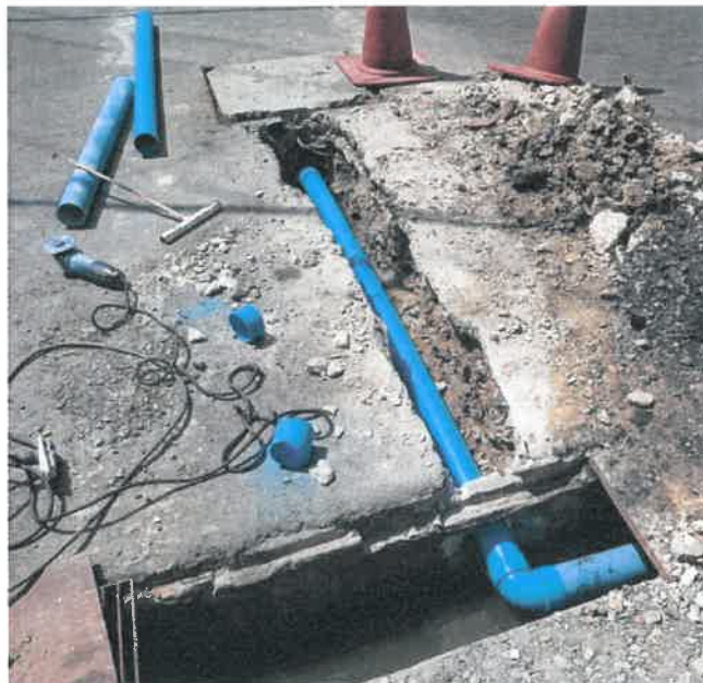
รูปที่ 3.3-20 แสดงการต่อท่อน้ำทิ้งจากถังบำบัดน้ำเสียของโครงการ เข้าสู่ระบบบำบัดน้ำเสียรวมของโรงพยาบาลพระมงกุฎเกล้า
